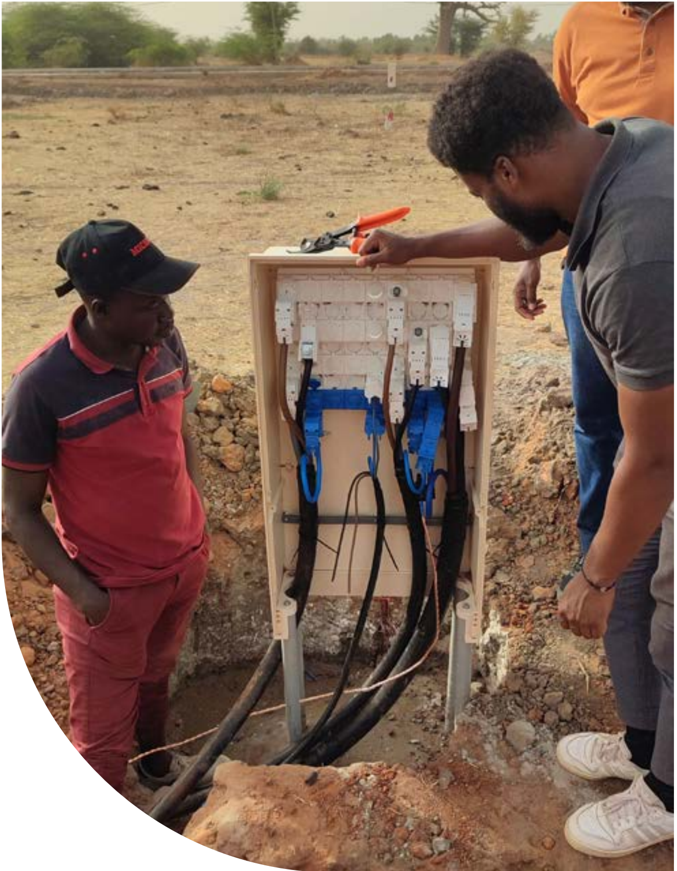
Installation d'un coffret REMIC - Sénégal
