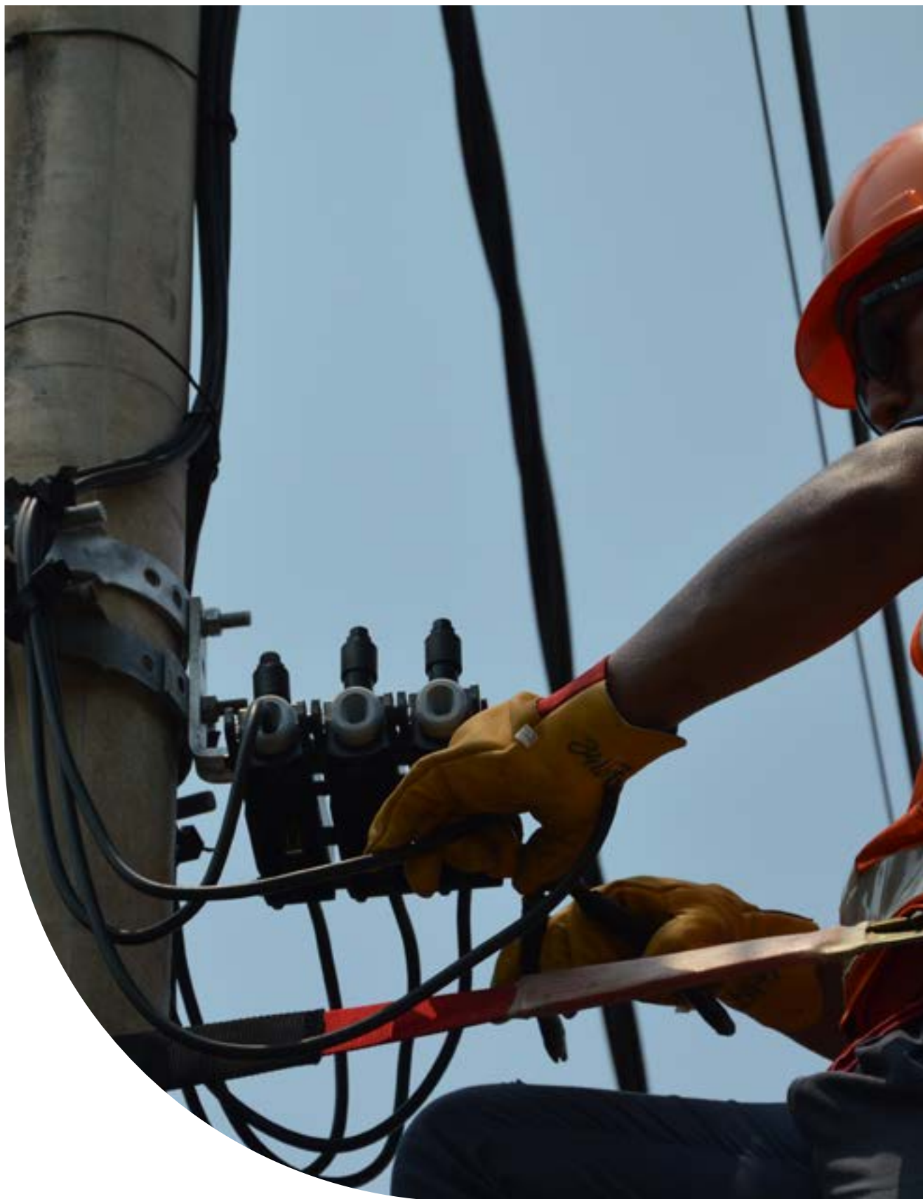
Installation d'un interrupteur sectionneur à fusible MICHAUD - Tonga
