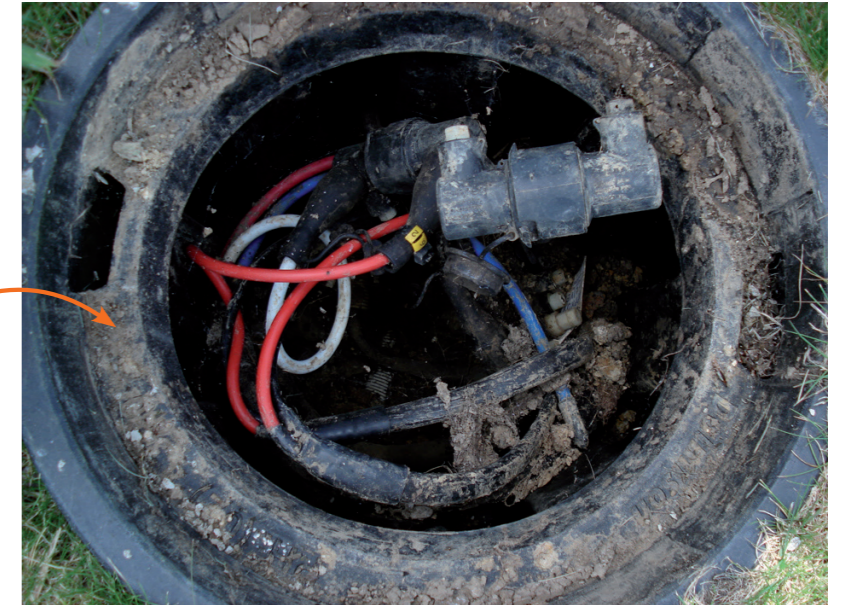
K199 - Lắp đặt trong hố ga
